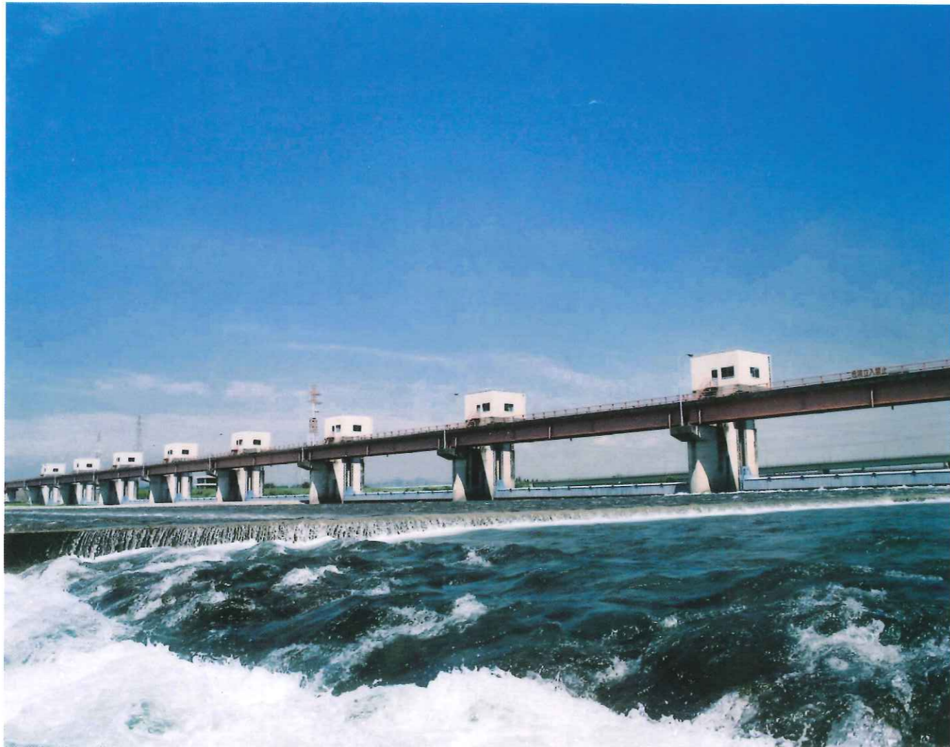
岡本頭首工全景
